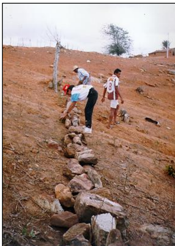
Barreiras de pedra para evitar erosão na propriedade, A/Es de Solânea.
