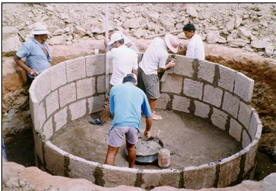
Agricultores sendo treinados para construir cisternas de placa, município de Solânea.
