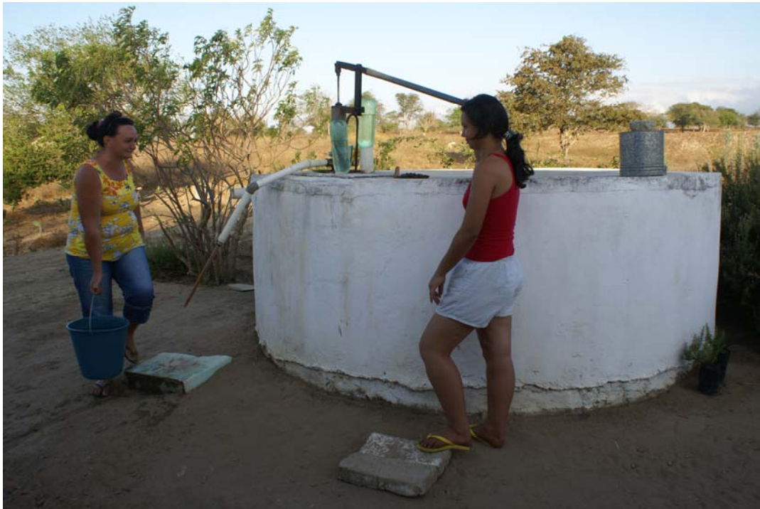
A instalação de bombas manuais melhorou a assepsia da água das cisternas e aliviou o trabalho das mulheres na retirada da água para uso doméstico.
