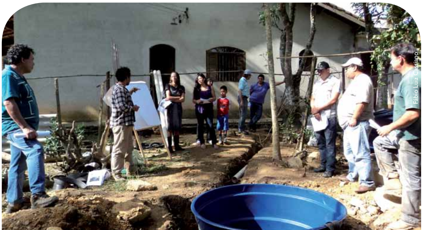
Oficina de saneamento rural: feito de fossa séptica biodigestora
