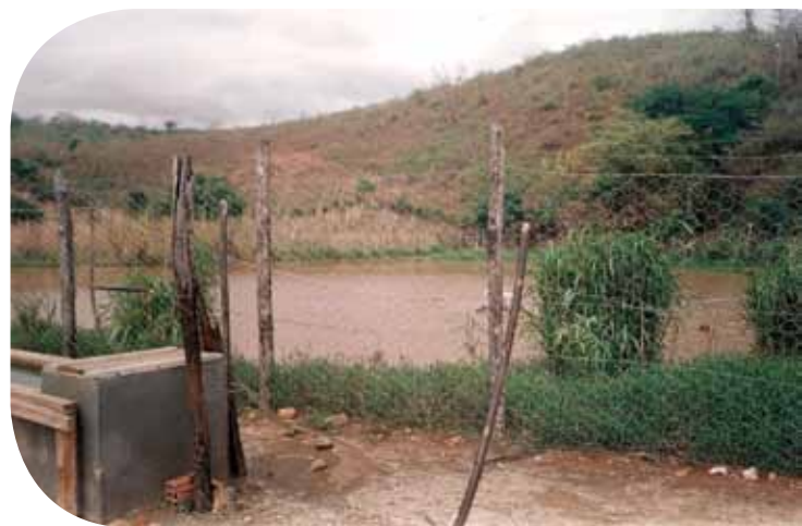
Vista parcial do açude de Empoeira e à esquerda, bebedouro para dessedentação animal
