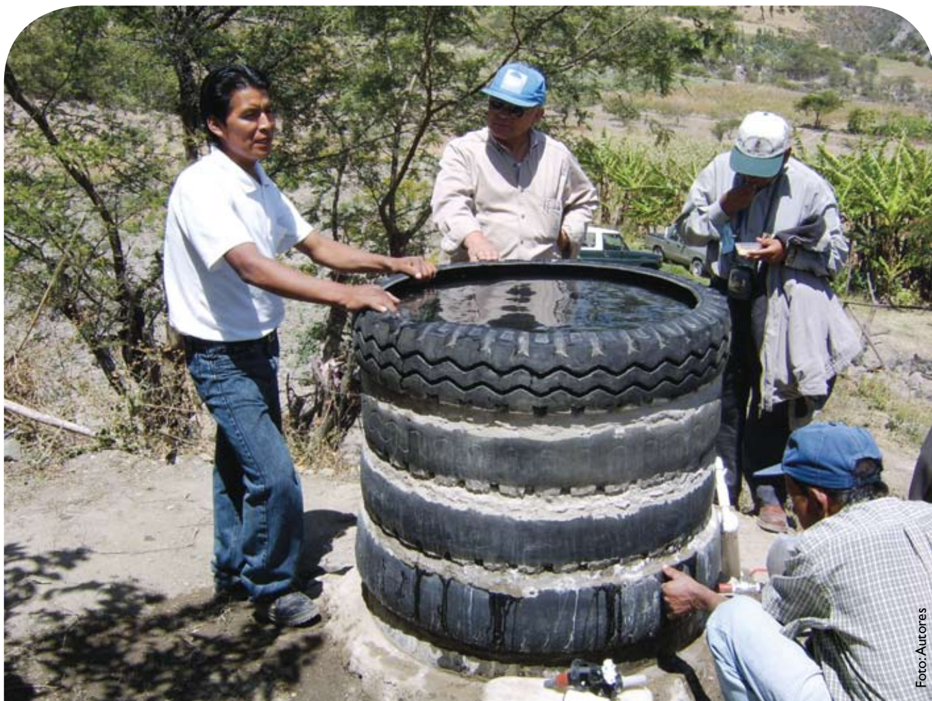
Seu Alfonso relata como seu aprendizado e suas inovações (por exemplo, este tanque feito com pneus reciclados) ajudaram a transformar sua propriedade e sua família no Vale de Chota, ao norte do Equador
