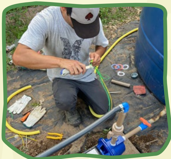
Instalação do sistema de irrigação de baixo custo na UP do Miguel
