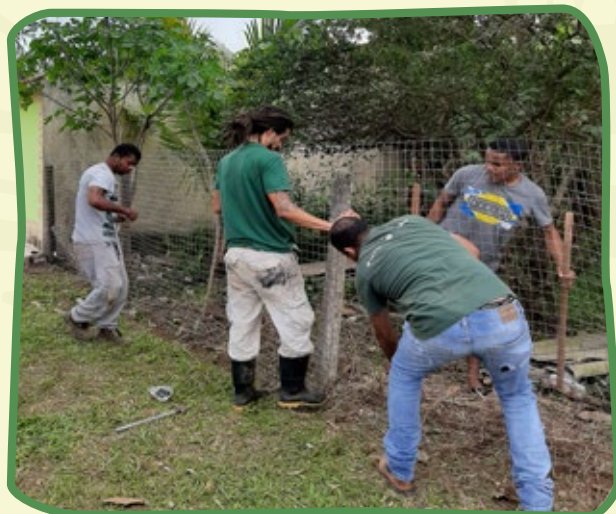
Colocação da cerca no Arranjo Local de Guaratiba
