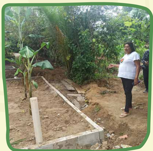
Leonídia Insfran compartilha o processo de construção da Bacia de Evapotranspiração, que foi instalada na Horta Comunitária do Quilombo Dona Bilina
